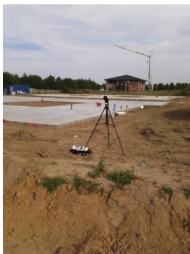
Figure 18 : Exemple de mesure acoustique
